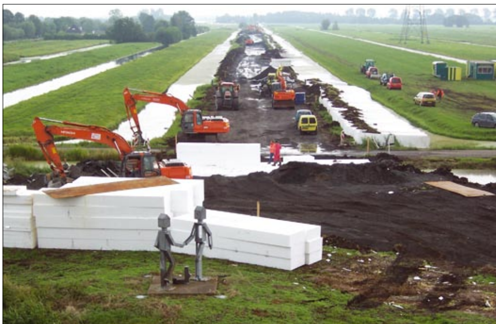
↑ Foto 1 Werk in uitvoering tijdens de reconstructie van de N475 – Zijdedeg met in de sloten de tijdelijk opgestapelde EPS-blokken
