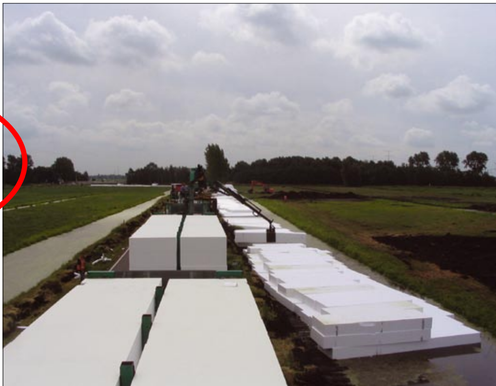
↑ Foto 2 Werk in uitvoering tijdens de reconstructie van de N475
